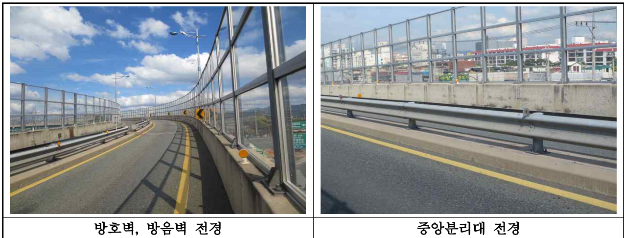
【사진 3.2.18】 난간 및 연석 전경
