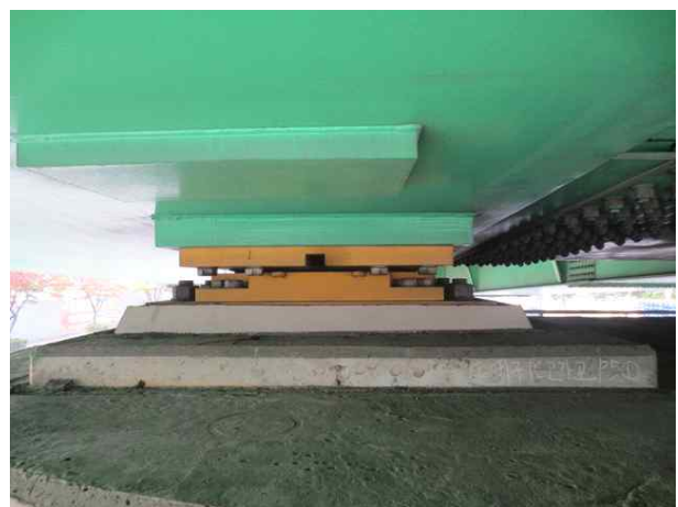
무수축물탈 균열 보수(P5 Sh1)
