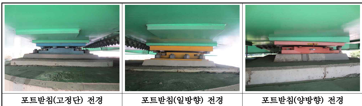
【사진 3.2.10】 교량받침 전경
