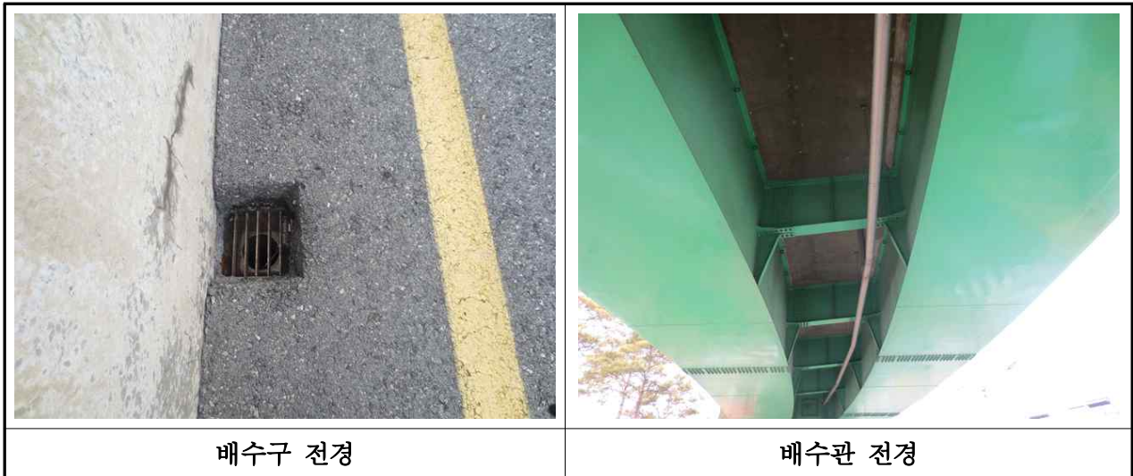
【사진 3.2.17】 배수구 및 배수관 전경
