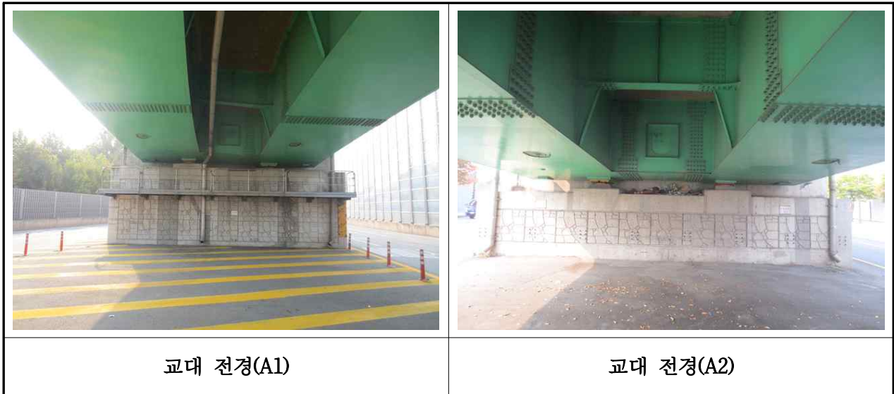
【사진 3.2.6】 교대 전경
