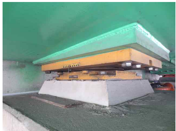
무수축물탈 균열 보수(A2 Sh1)
