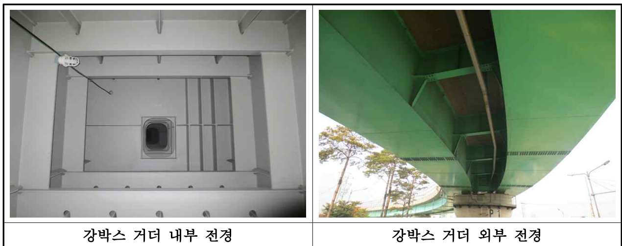
【사진 3.2.3】 강박스 거더 전경
