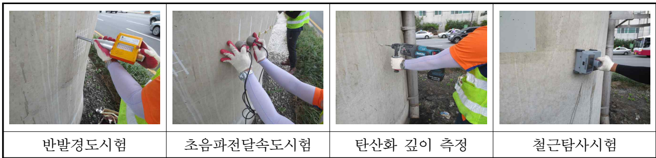
【사진 3.3.1】 콘크리트 내구성조사 전경
