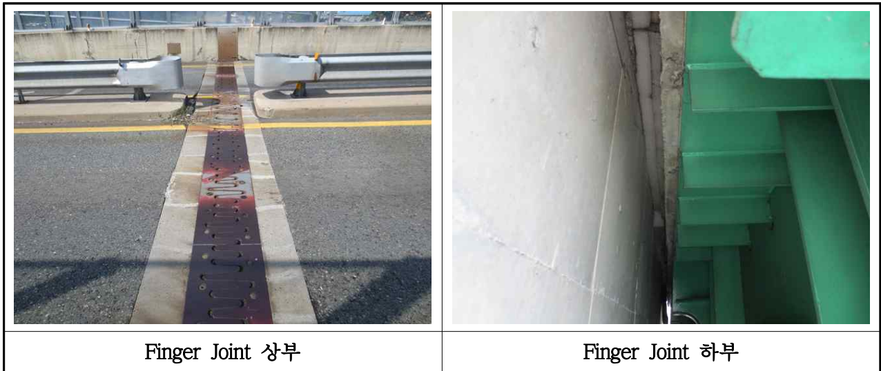
【사진 3.2.13】 신축이음장치 전경
