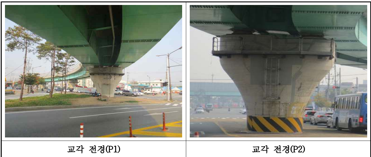
【사진 3.2.8】 교각 전경
