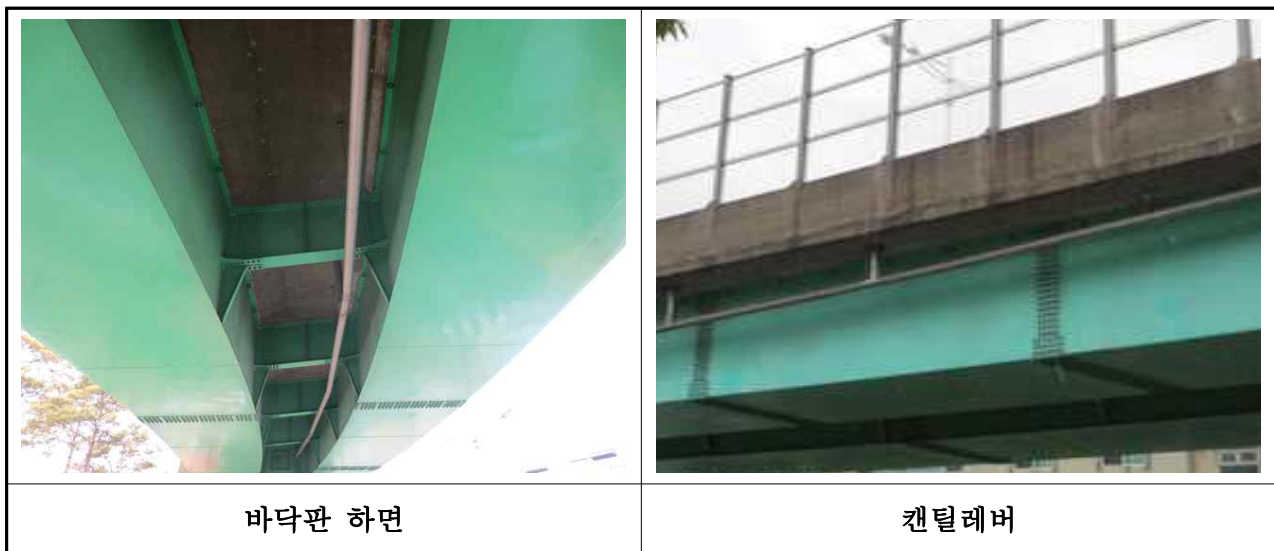
【사진 3.2.1】 바닥판 전경
