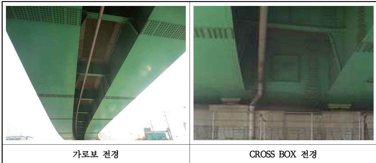
【사진 3.2.5】 가로보 및 CROSS BOX 전경
