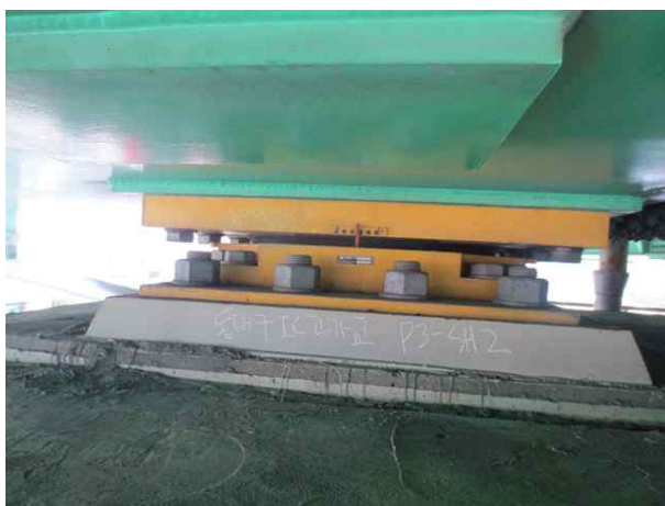
무수축물탈 균열 보수(P3 Sh2)
